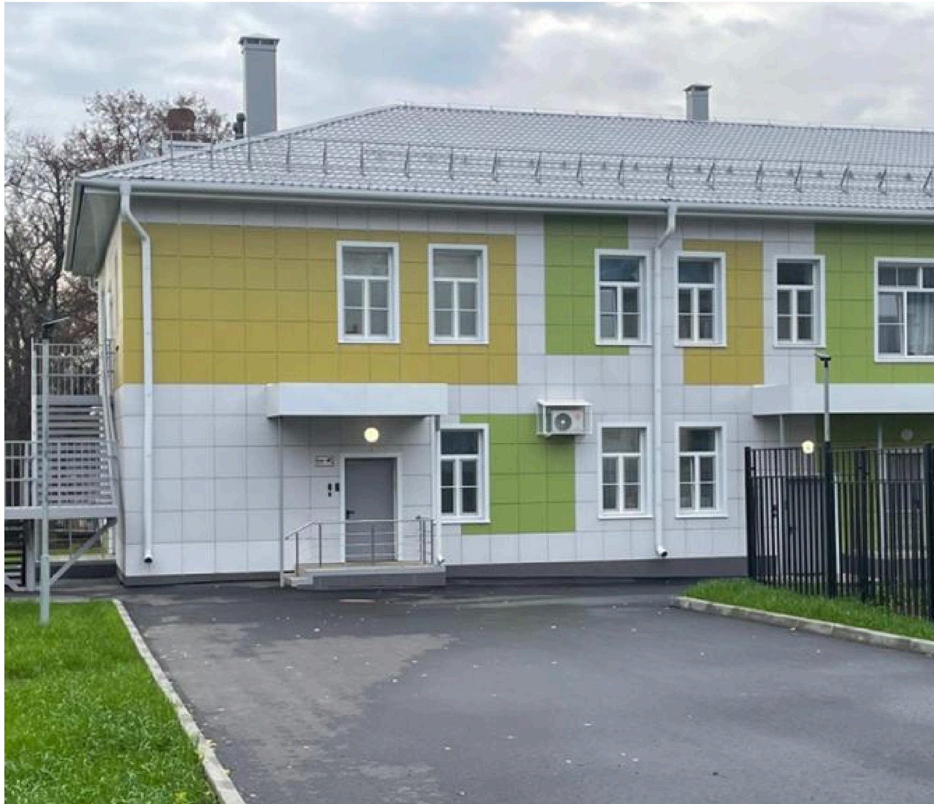
ДОМОДЕДОВСКИЙ РАЙОН ДОУ ВЕРТИКАЛЬНО-ГОРИЗОНТАЛЬНАЯ ПОДСИСТЕМА КЕРАМОГРАНИТ
