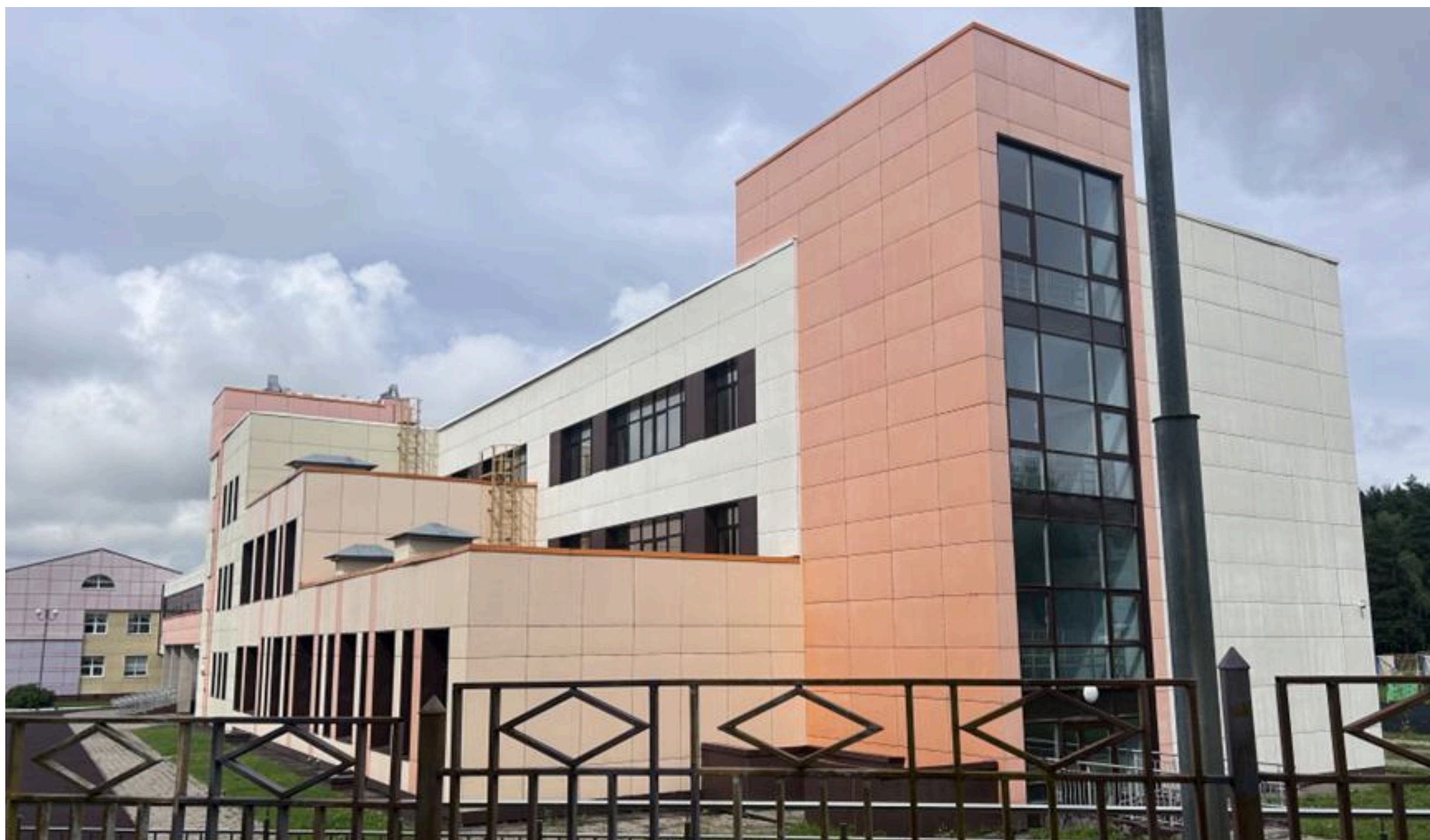
ТИНАО ДОУ ВЕРТИКАЛЬНАЯ ПОДСИСТЕМА ШИРОКОФОРМАТНЫЙ КЕРАМОГРАНИТ
