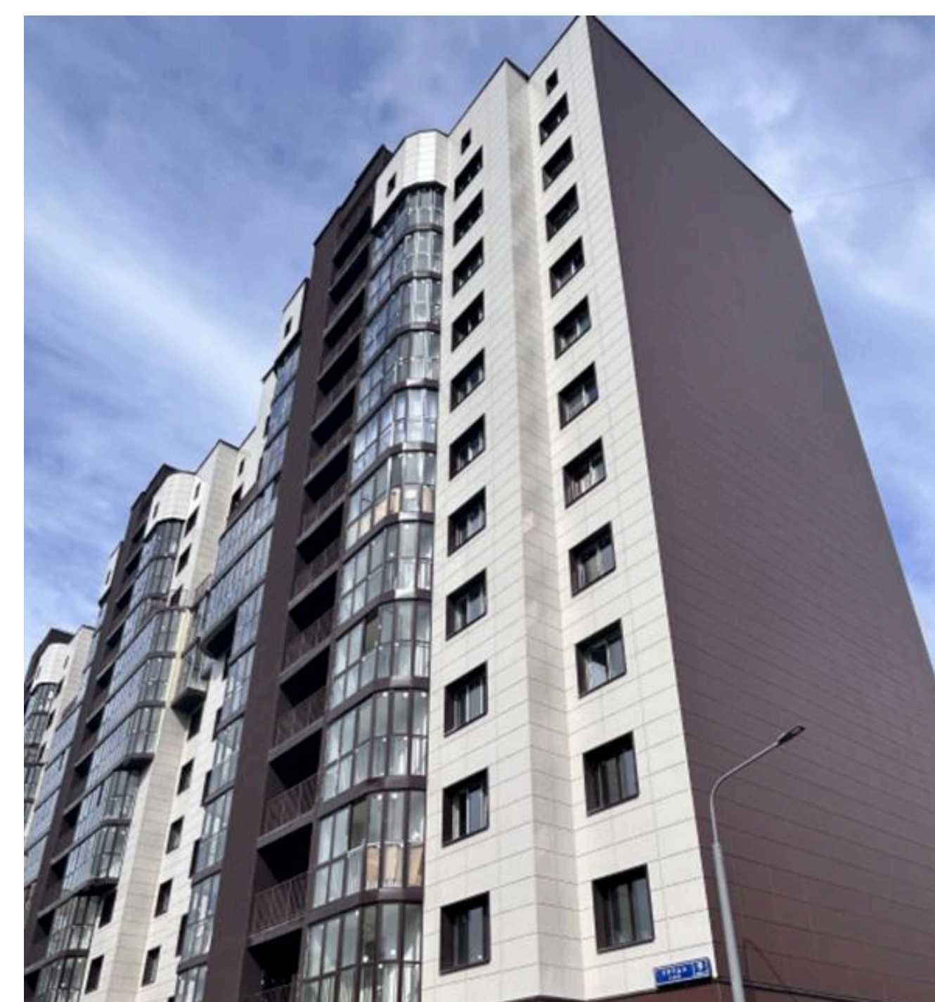
Г.РОСТОВ-НА-ДОНУ ЖК ТЕАТРАЛ ФАСАДНАЯ СИСТЕМА С ПОЛИМЕРНЫМ ПОРОШКОВЫМ ПОКРЫТИЕМ
